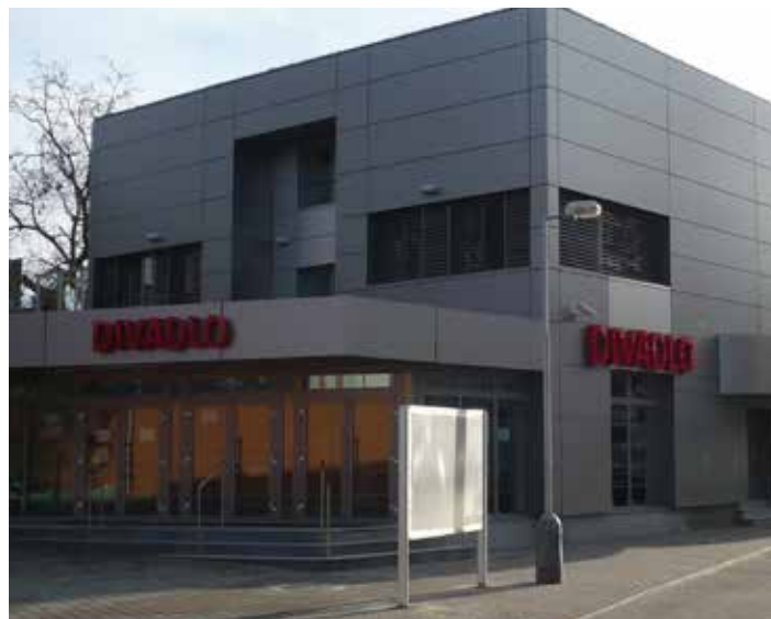
Nová sokolovna z roku 1931 byla v letech 2007–2009 přestavěna na Divadlo U22 a původní sokolovna zůstala v původní architektonické podobě jako přístavba k němu.
