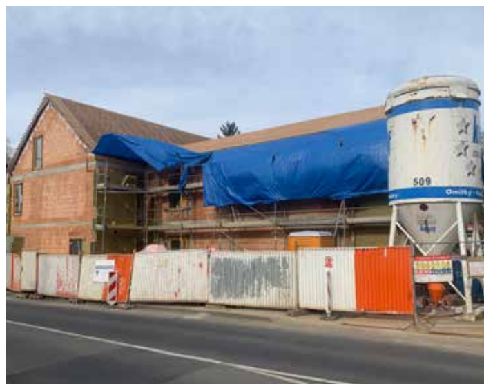
...a takto vypadala stavba v dubnu loňského roku.
