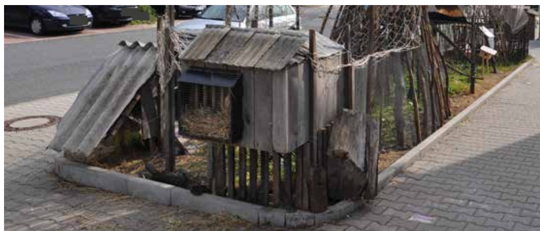
Všimněte si vlnité střešní kritiny z azbestu, která je zdravotně závadná. Tenká azbestová vlákna mohou způsobit rakovinu.
