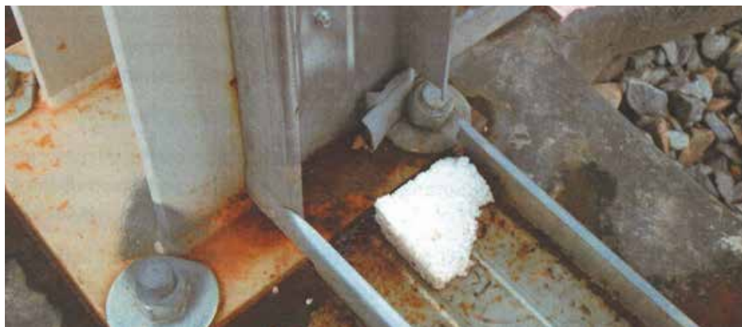
Současný stav polyfunkčního domu v Pitkovicích bohužel znemožňuje záchranu nedodělané stavby.
