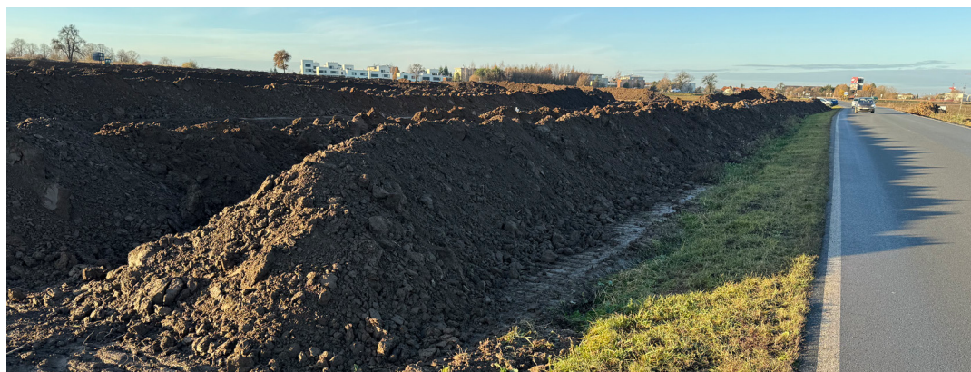
Příprava stavby dálničního okruhu mezi Říčany a Uhřetěvesi začátkem prosince. Zatím zde jenom odstraňovali ornici.
