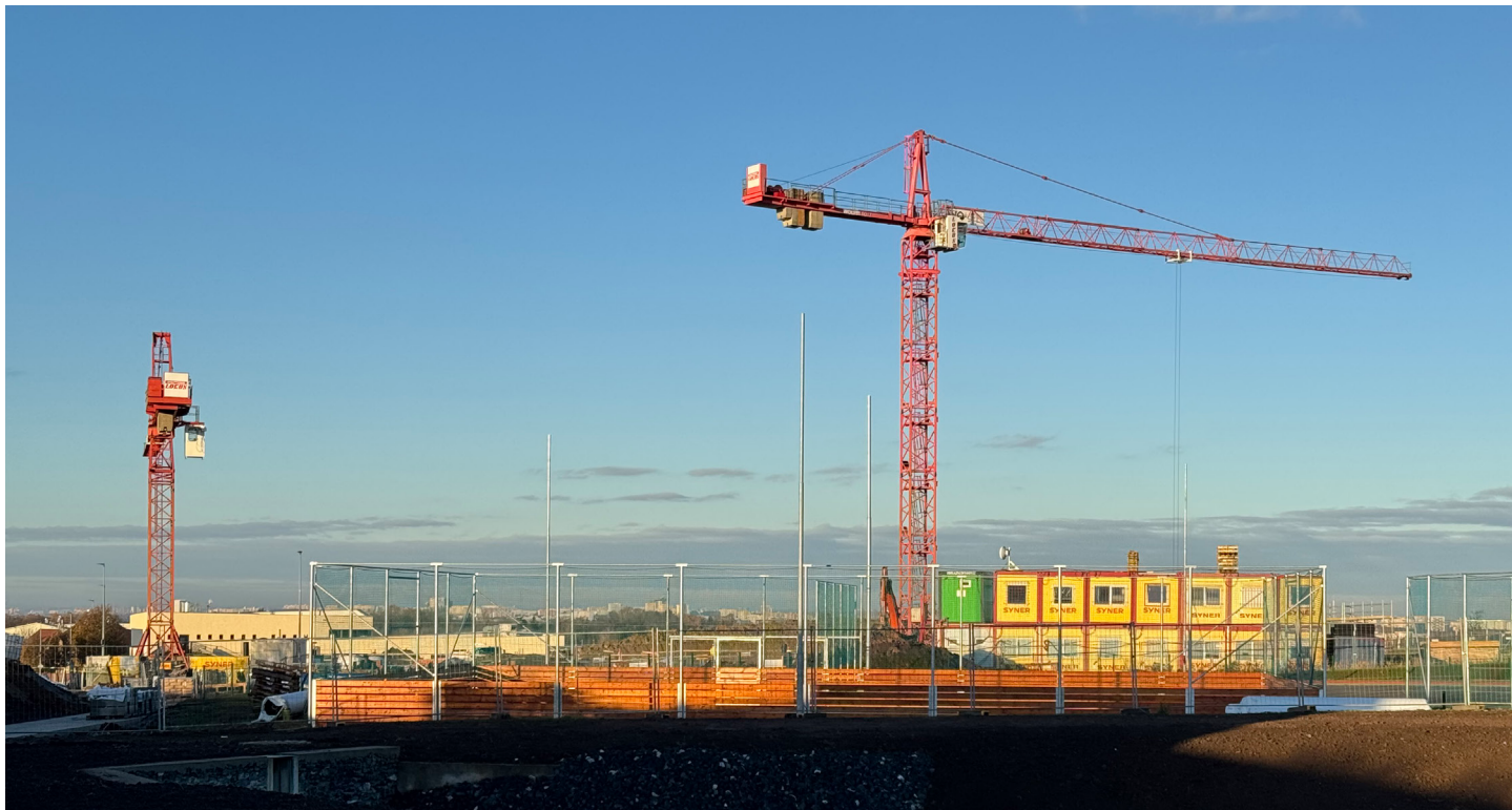
Zatímco u nás se do země ještě nekoplo, v nedalekých Kolovratech svou školu již stavět začali. Přestože měli projekt později než my.
