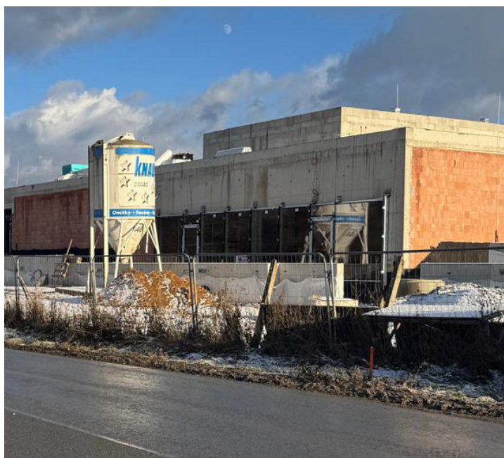
ZŠ Pitkovice (Polyfunkční dům) – dnešní stav: hrubá stavba dokončena
